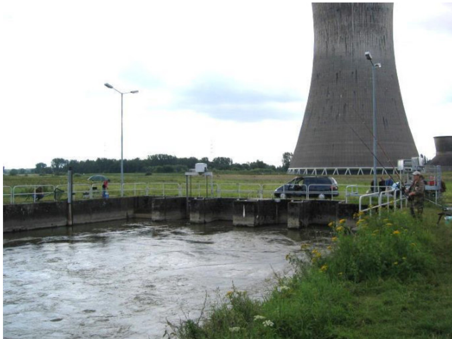
Abbildung 30: Ehemalige Kühlwassereinleitung in die Lippe bei Hamm (Quelle: O. Niepagenkemper).
